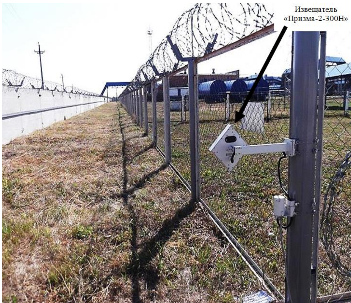
Рис. 4.9. Пример установки на втором рубеже радиоволнового извещателя «Призма-2/300Н»
