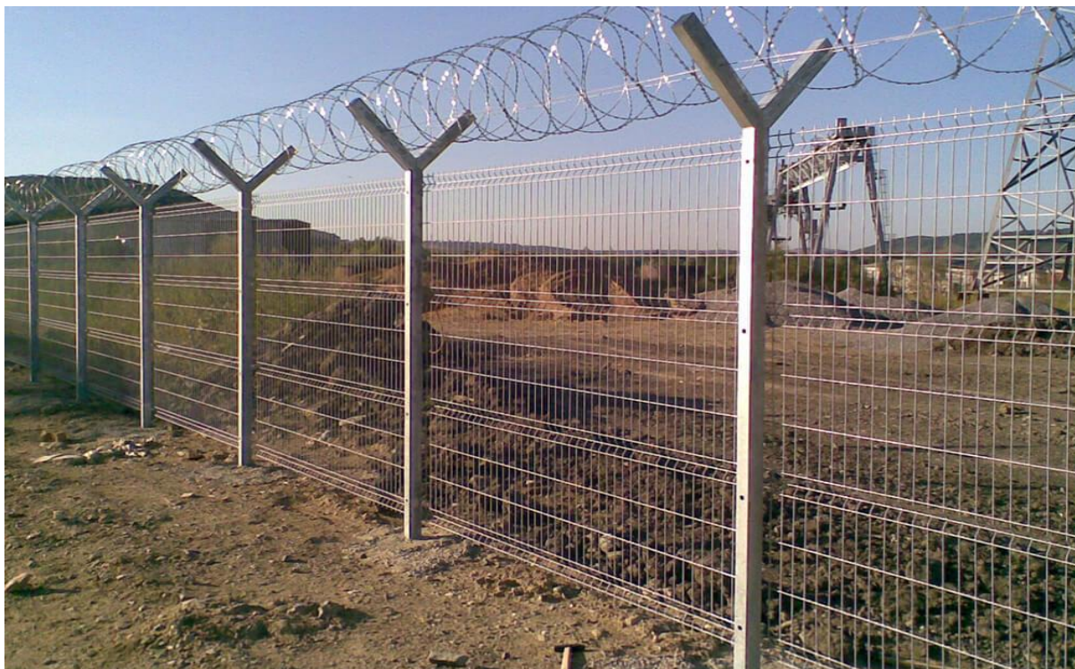
Рис. 1.7. Основные ограждения с просматриваемым гибким полотном (гибкая сетка ССЦП)
