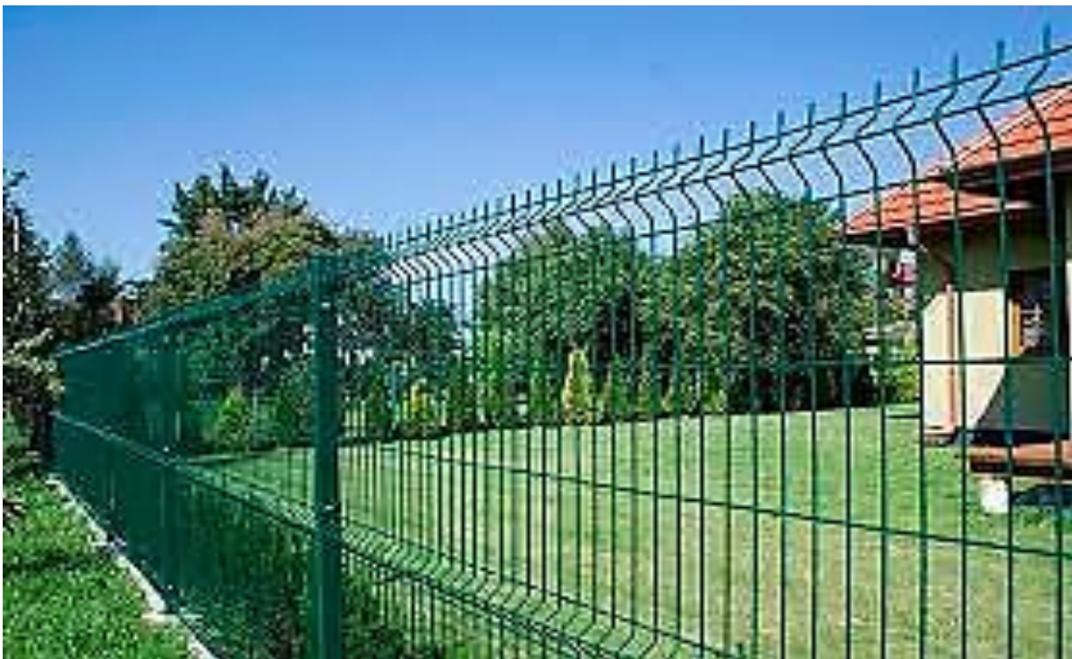
Рис. 1.9. Основное ограждение с просматриваемым жестким полотном на ленточном фундаменте (сварная сетчатая панель)
