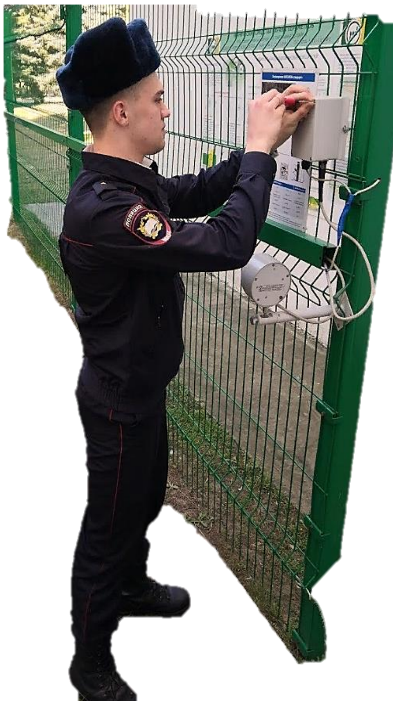
Рис 4.13. Установка радиоволнового извещателя «Призма-3-24/250НР1» на заграждение
