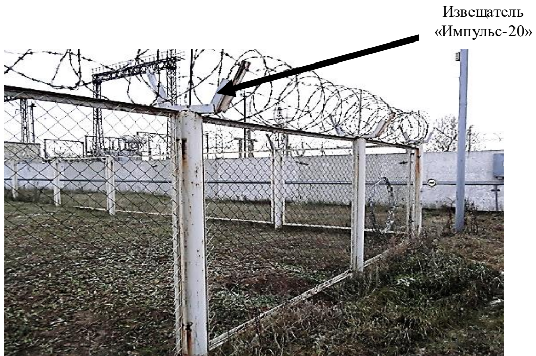
Рис. 4.8. Пример установки извещателя «Импульс-20»
