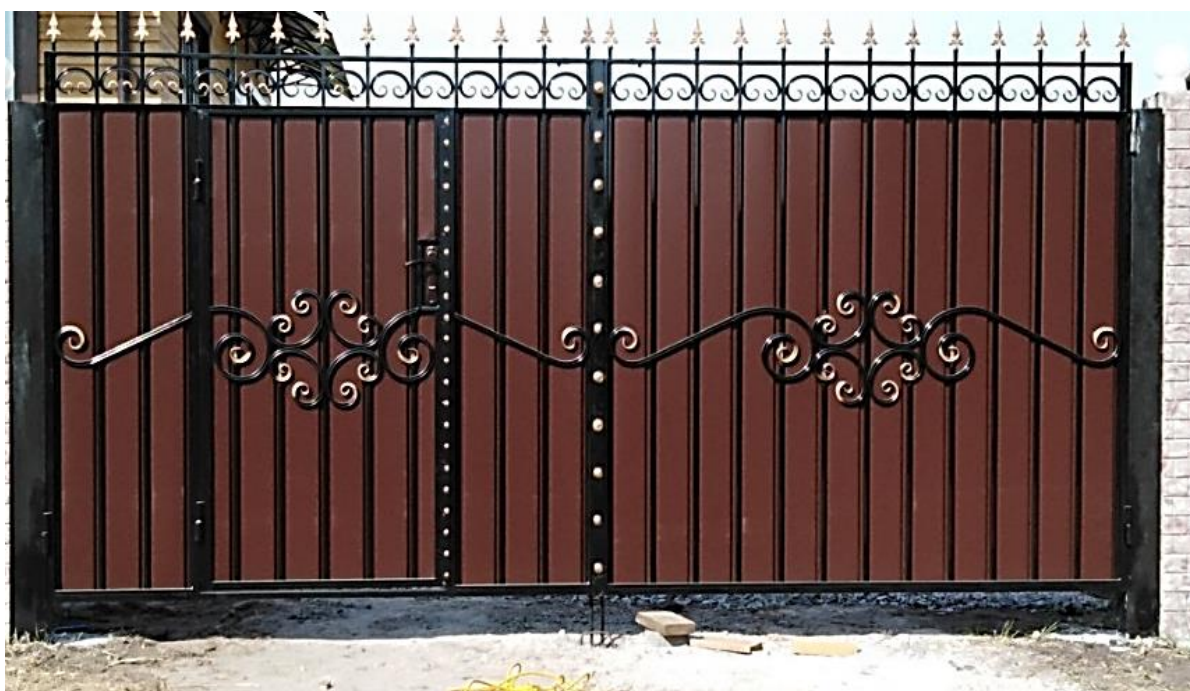
Рис. 1.21. Ворота 3-го класса защиты, выполненные из сплошного металлического листа высотой не менее 2,5 метра
