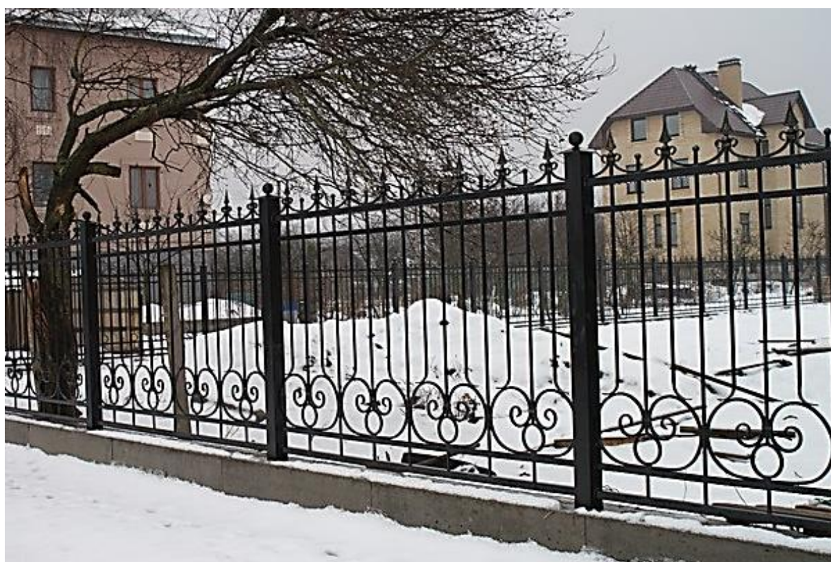
Рис. 1.11. Декоративное металлическое основное ограждение на ленточном фундаменте
