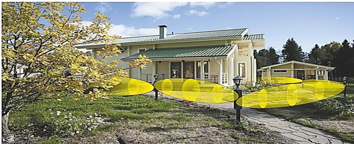
Рис. 4.14. Пример применения двухпозиционного радиоволнового извещателя «Сегмент-3-10», выполненного в виде уличного светильника, для охраны периметра территории административного здания
