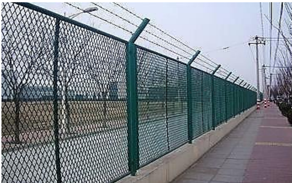
Рис. 1.10. Основное ограждение с просматриваемым жестким полотном на ленточном фундаменте (просечно-вытяжной лист)
