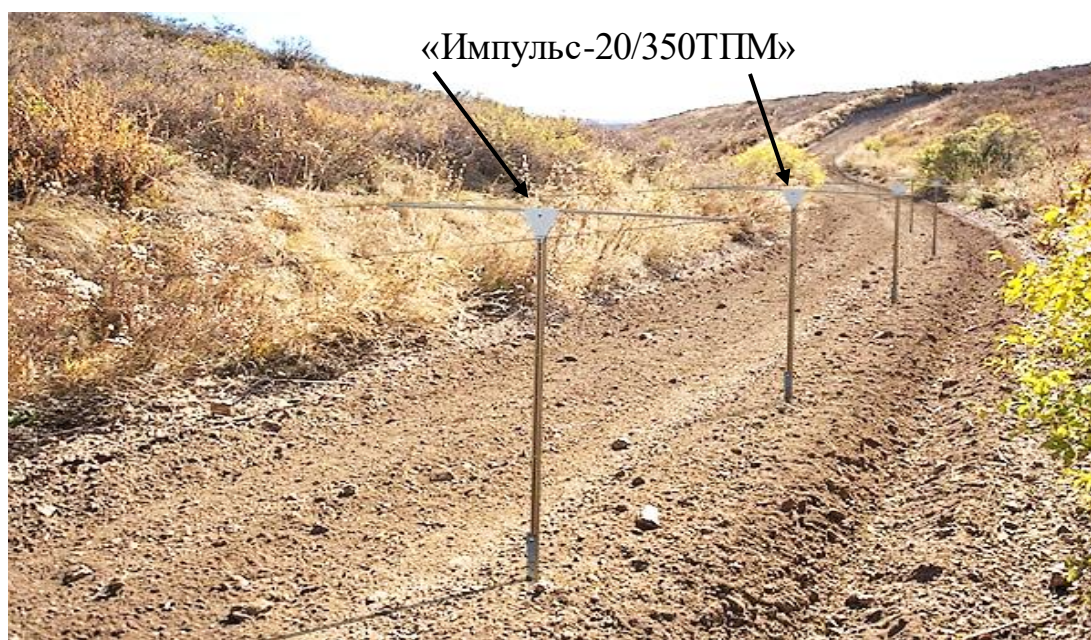
Рис. 4.11. Пример установки проводно-волнового извещателя «Импульс-20/350ТПМ»
