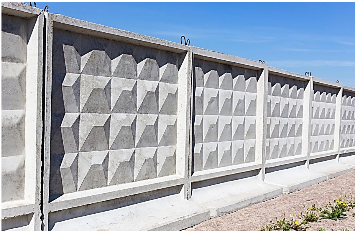
Рис. 1.12. Основное ограждение сплошного заполнения (железобетонное ограждение)
