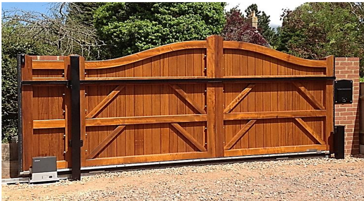
Рис 1.20. Деревянные ворота 2-го класса защиты со сплошным заполнением полотен толщиной не менее 40 миллиметров
