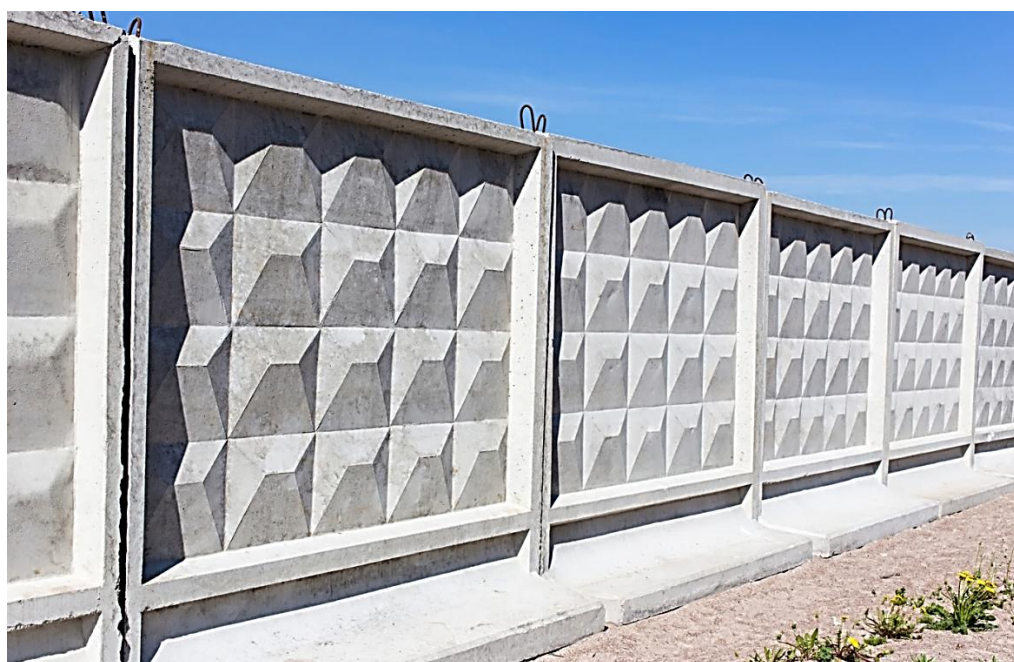
Рис. 3.6. Основное ограждение сплошного заполнения (железобетонное ограждение)
