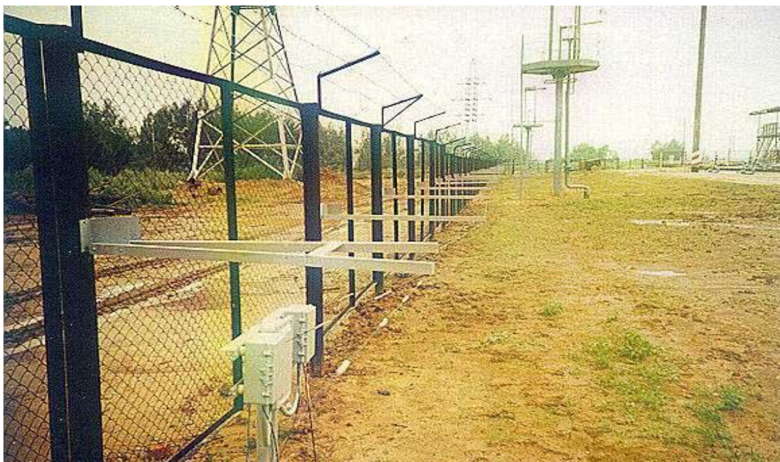
Рис. 3.7. Наклонный козырек из колючей проволоки, скрученной колючей ленты (СКЛ), армированной скрученной колючей ленты (АСКЛ)
