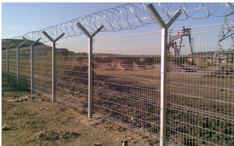
Рис. 3.1. Основные ограждения с просматриваемым гибким полотном (гибкая сетка ССЦП)
