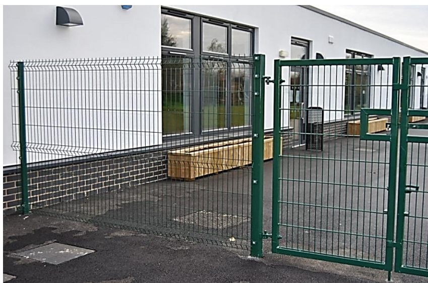
Рис. 3.13. Калитка 1-го класса защиты, выполненная из некапитальных конструкций высотой не менее 2 метров
