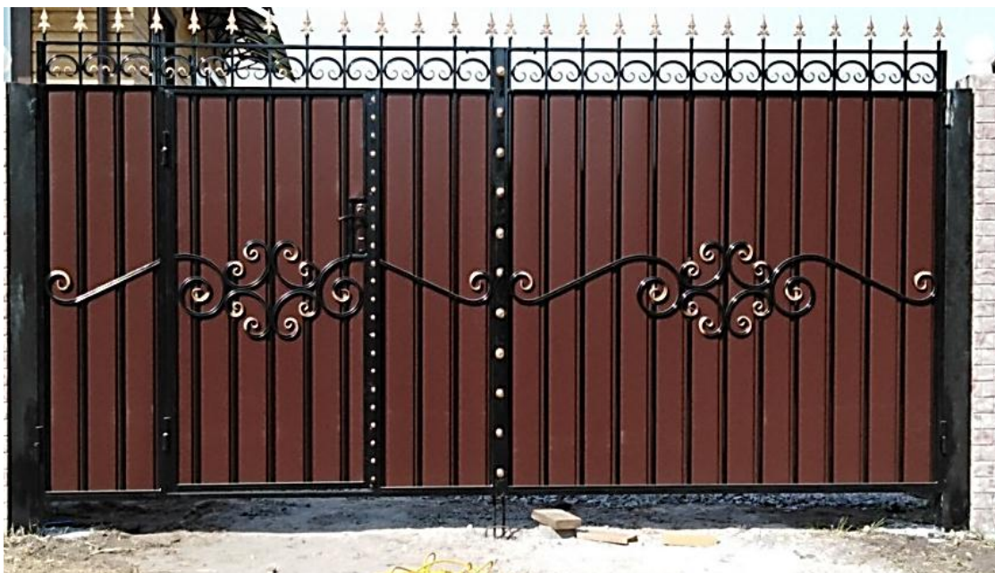
Рис. 3.15. Ворота 3-го класса защиты, выполненные из сплошного металлического листа высотой не менее 2,5 метра
