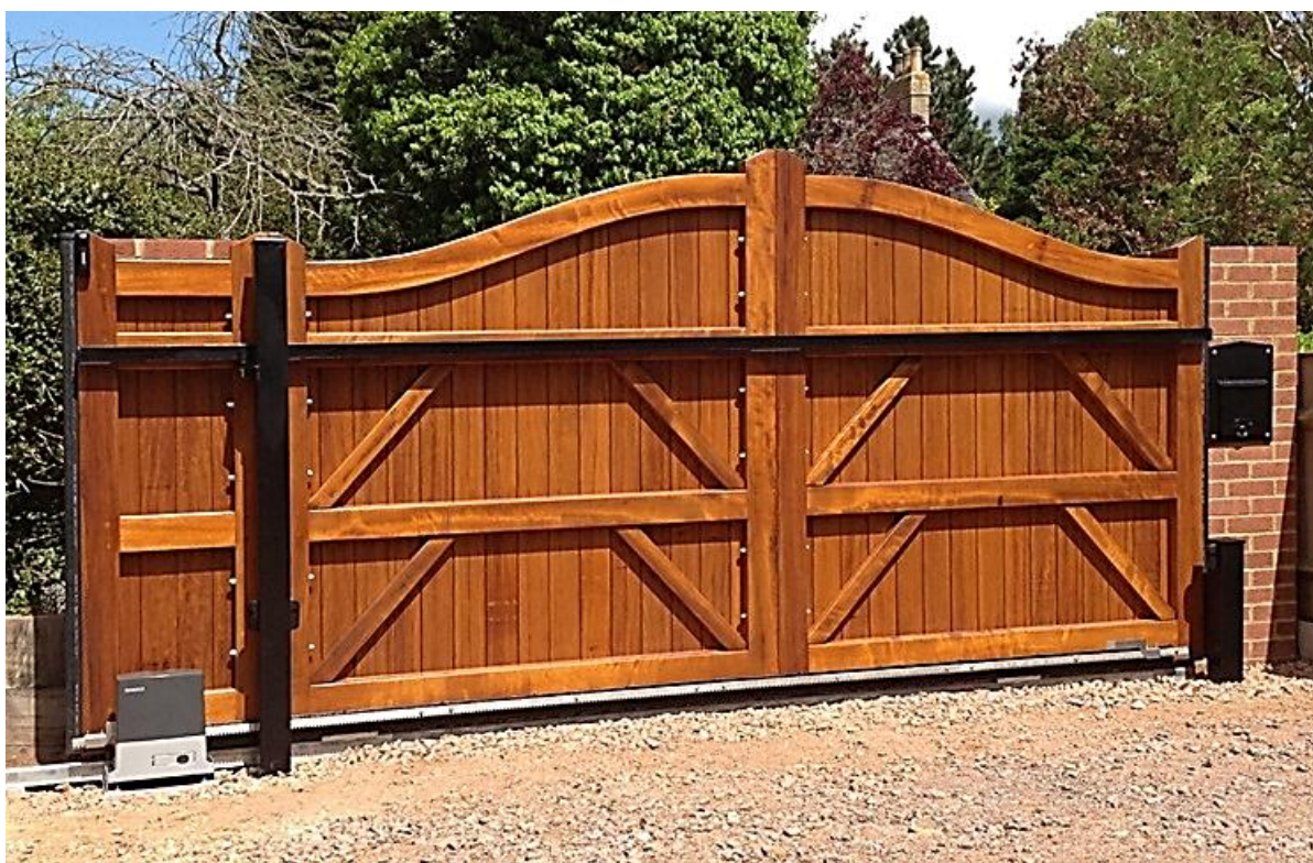
Рис 3.14. Деревянные ворота 2-го класса защиты со сплошным заполнением полотен толщиной не менее 40 миллиметров
