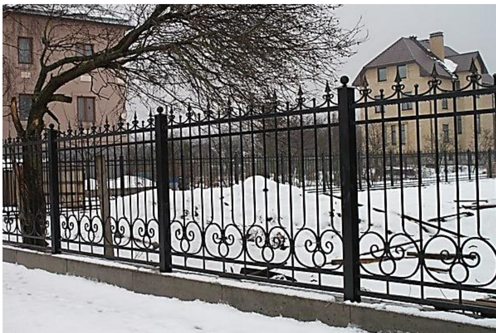
Рис. 3.5. Декоративное металлическое основное ограждение на ленточном фундаменте
