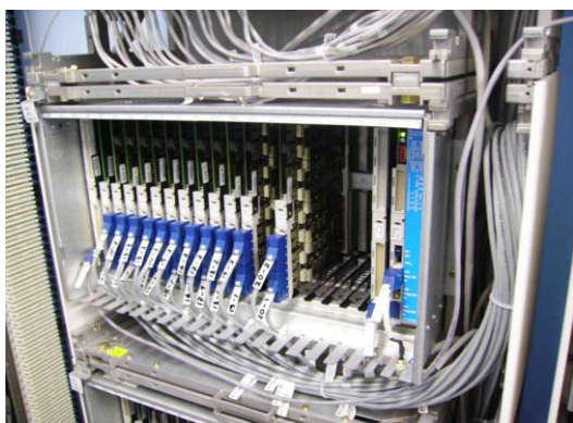
Рисунок 2. Средство коммутации (автоматическая телефонная станция)
