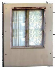
Рис. 9. Стена с оконным проемом
