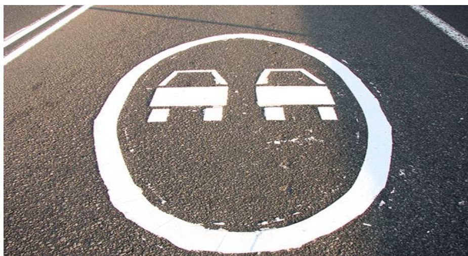
Рис. 4. Несоблюдение геометрических параметров горизонтальной дорожной разметки в плане
