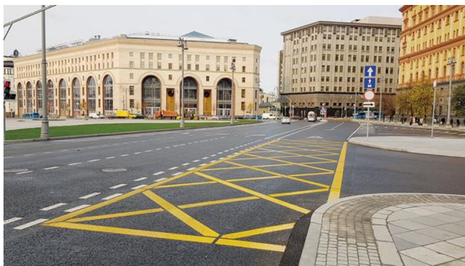
Рис. 8. Специальная дорожная разметка «Зона перекрестка» в виде перекрестия желтых диагональных линий в квадрате, обозначающего границы перекрестка
