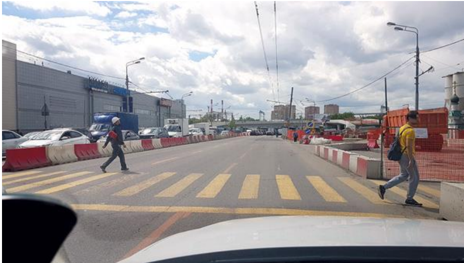
Рис. 6. Временная горизонтальная дорожная разметка желтого цвета (разметка 1.12 и 1.14) и оранжевого цвета (1.1 и 1.6)
