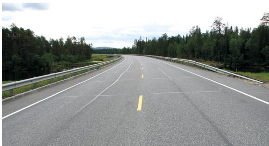
Рис. 9. Проведение эксперимента по применению горизонтальной дорожной разметки желтого цвета для разделения транспортных потоков в условиях зимней эксплуатации в Республике Карелия и Мурманской области
