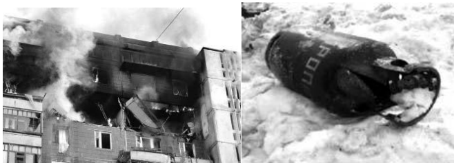
Рис. 83. Взрыв газового баллона в многоэтажном доме (физический взрыв)
