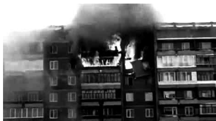
Рис. 85. Взрыв трансформатора в многоэтажном доме (электромагнитный взрыв)
