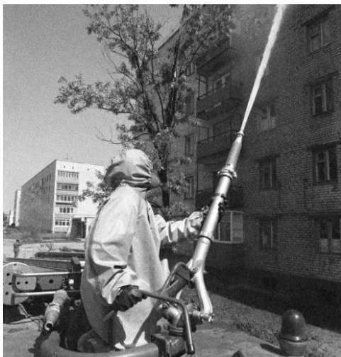
Фото 81. Проведение дезактивации здания
