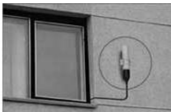
Фото 57. Установка блока детектирования на стене здания
