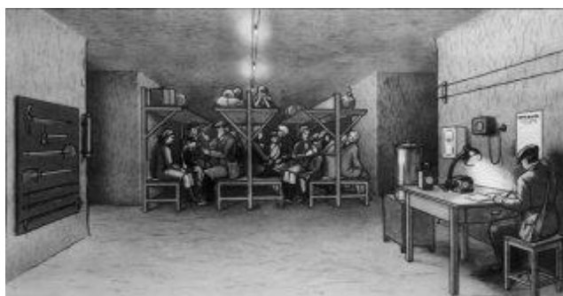
Рис. 15. ПРУ в подвальном помещении жилого дома
