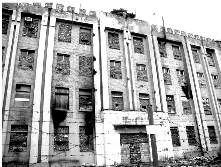
Рис. 6. Размещение амбразур в проемах окон
