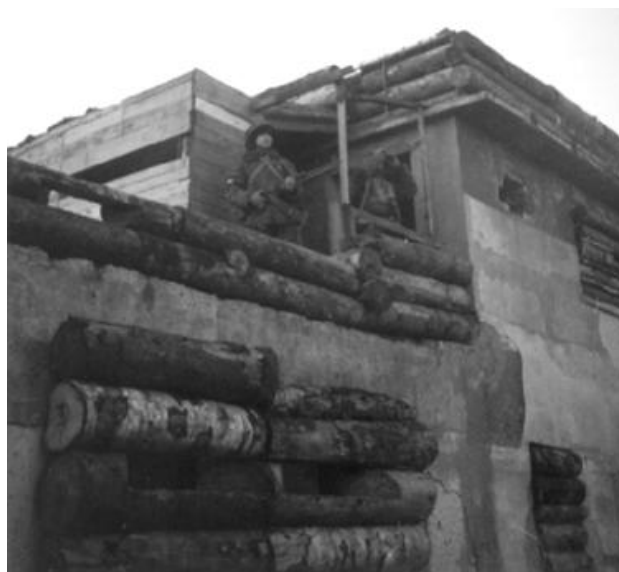
Рис. 5. Вариант оборудования огневых точек на крыше здания
