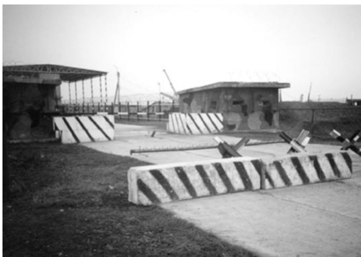
Рис. 11. Вариант устройства противотаранных заграждений на подъездных путях
