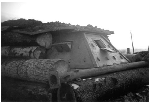
Рис. 3. Оборудование огневой точки с использованием бронеколпака
