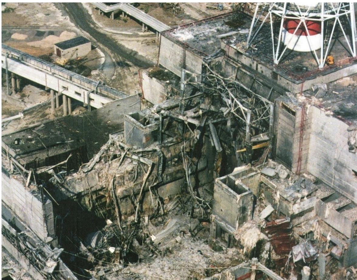
Рисунок 22 – Вид с вертолета на 4-ый энергоблок Чернобыльской АЭС после аварии
