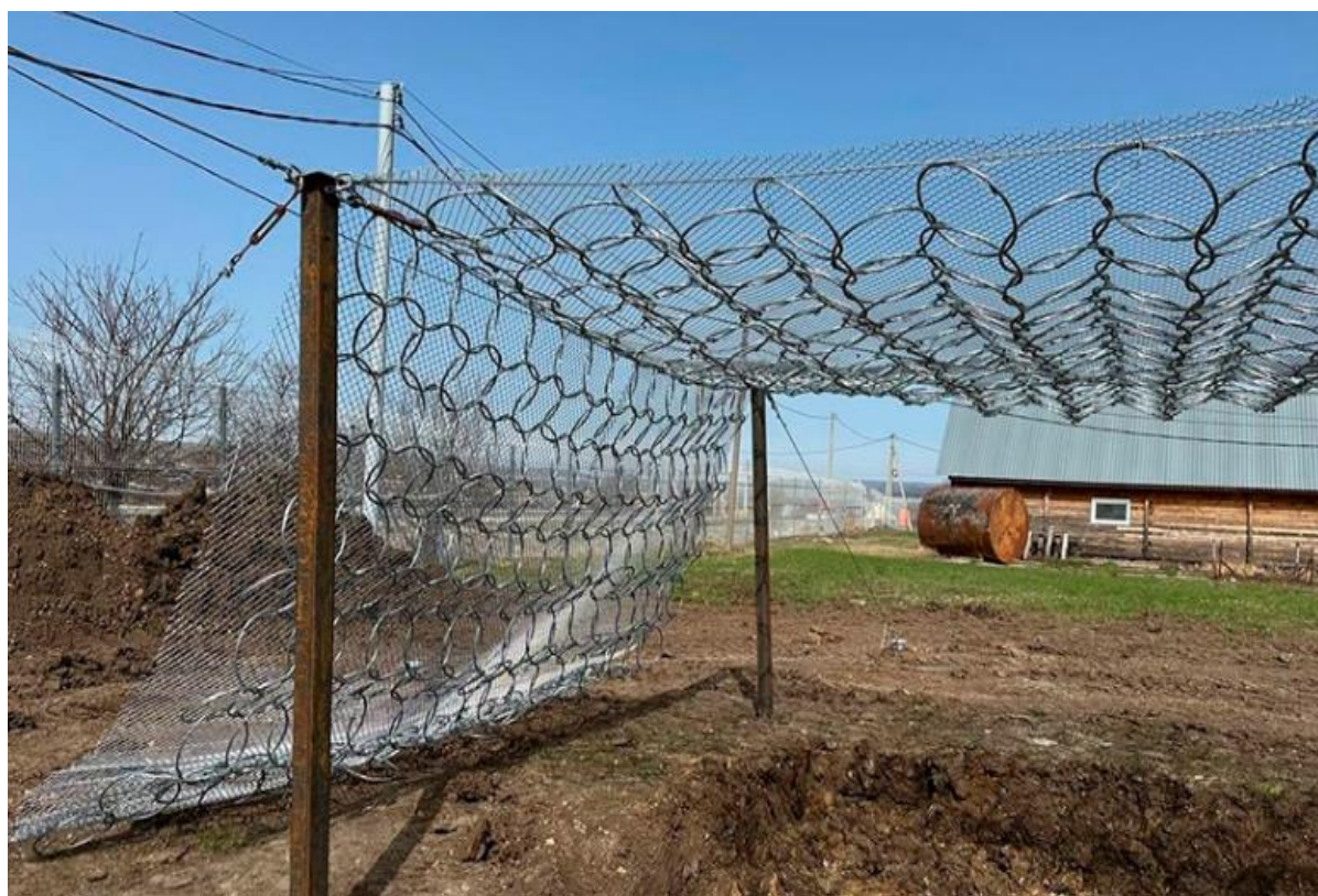
Рис. 2. Внешний вид защитного экрана от дронов-камикадзе
