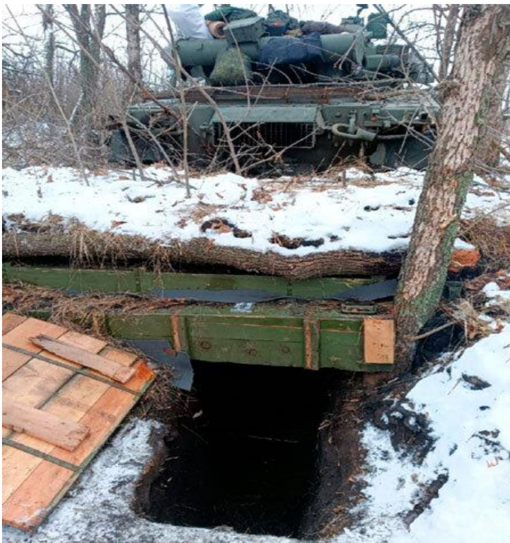
Рис. 12. Блиндаж с мощным накатом и дверью, расположенной под защитой дерева
