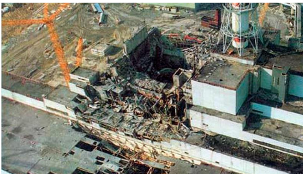
Рис. 10. Авария на ЧАЭС 1986 г. (фото www.Ariary.by )
