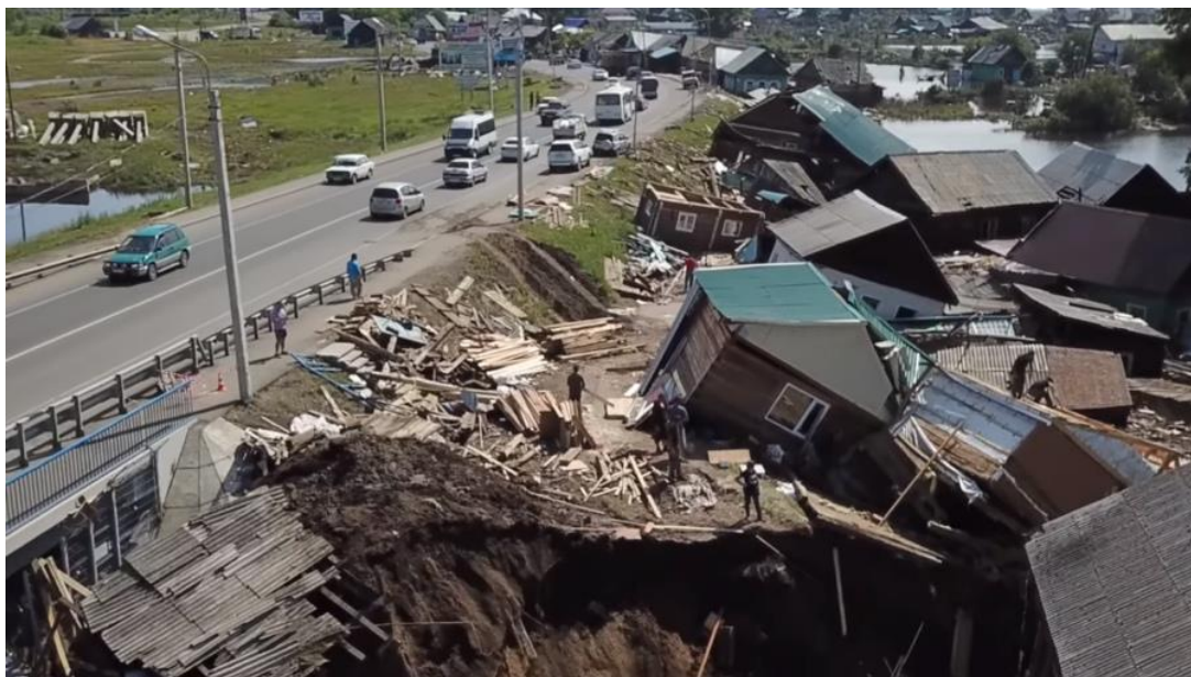
Рис. 7. Последствия наводнения в г. Тулун (фото www.Cont.ws )
