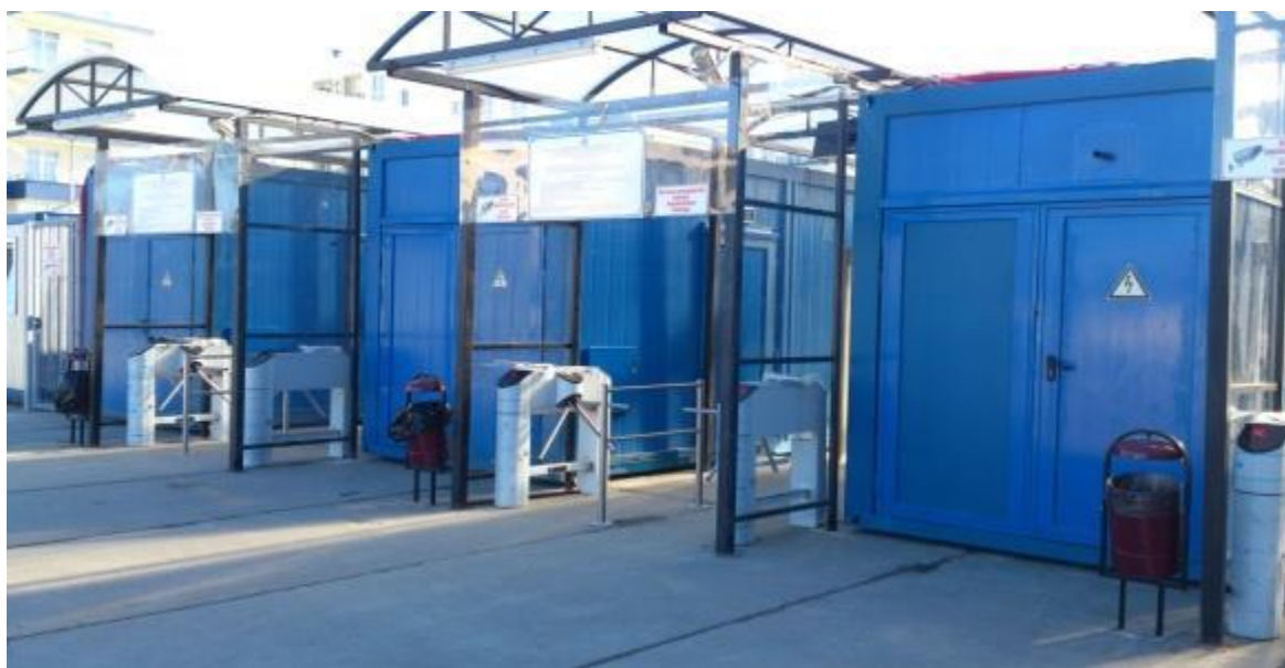
Рис. 2.20. Передвижной автономный комплекс персонального досмотра пассажиров, их ручной клади и багажа при посадке в автобусы и иные автотранспортные средства на необорудованных для целей досмотра площадках – Шток-ПКП
