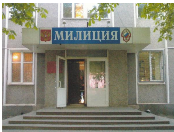
Здание Яковлевского РОВД
