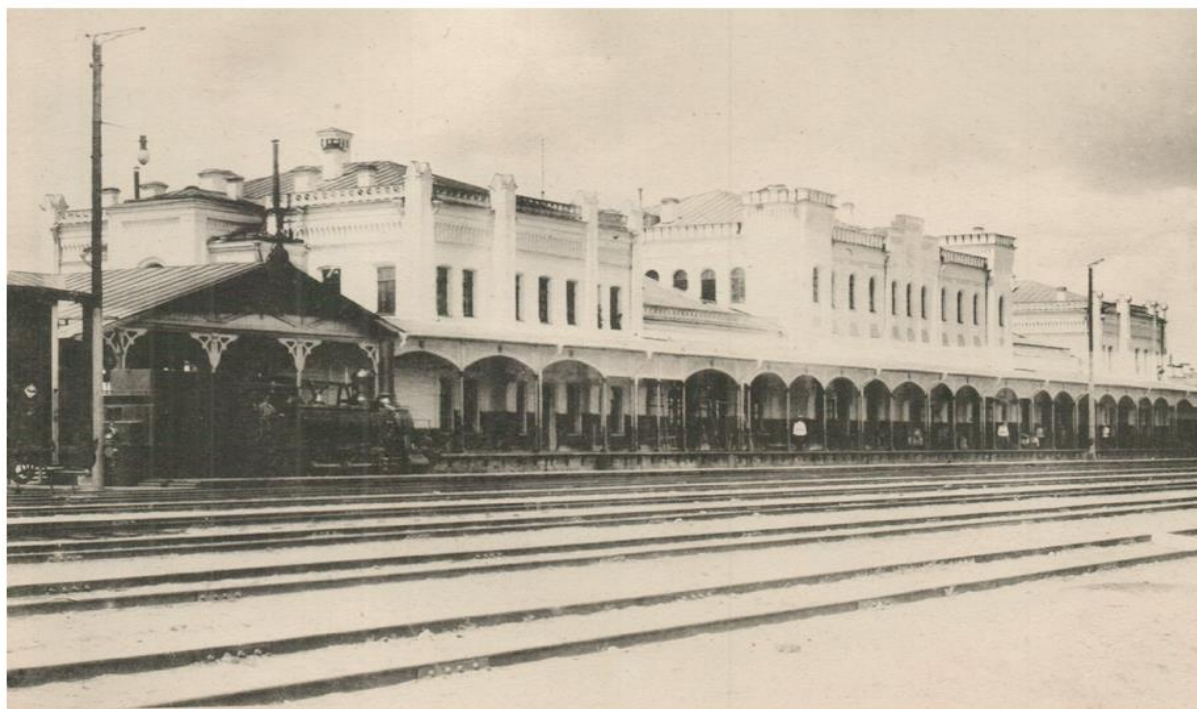
Рисунок 4. Железнодорожный вокзал станции Курск на линии Москва – Харьков
