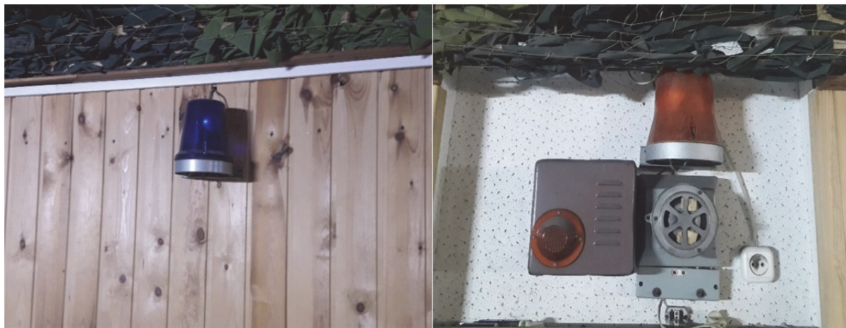
Рис. 73. Световые сигнальные устройства (мигалки)
