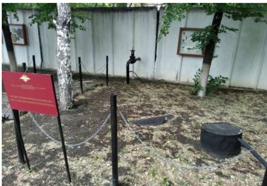
Учебно- тренировочная площадка «Место врезки в нефтепровод»
