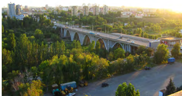
5. Вот дорога и мост.
