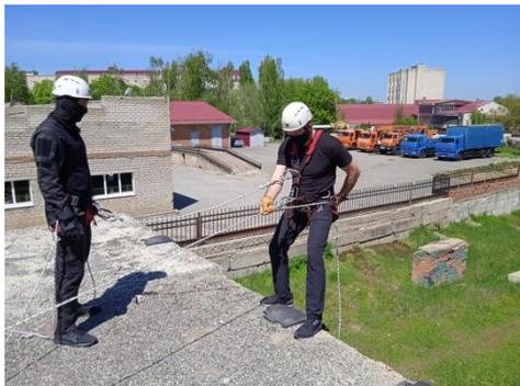
Рисунок 19. Верхняя ненагруженная страховка (обеспечивается основной веревкой, идущей сверху и удерживаемой страхующим);
