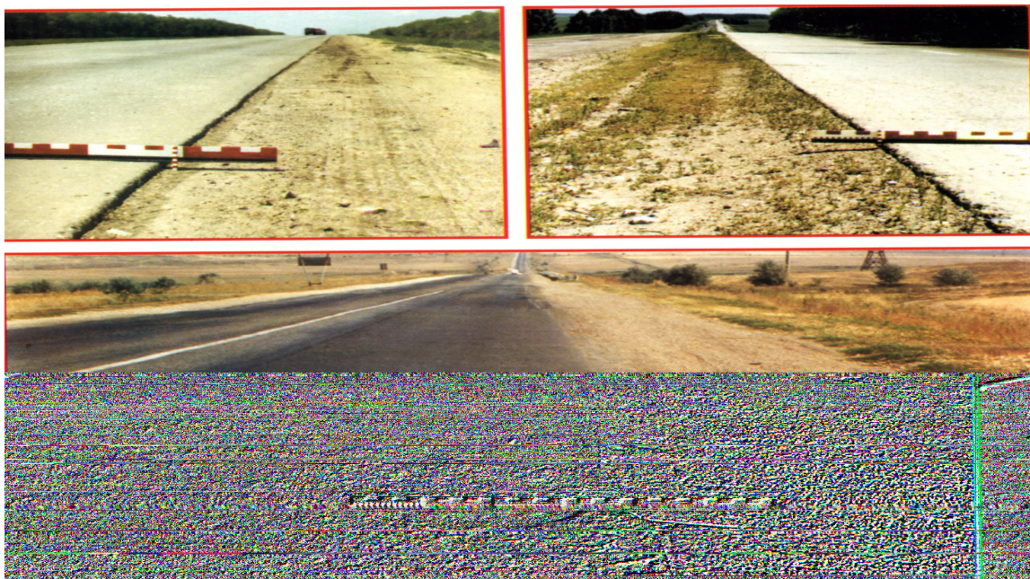
Рис. 3. Пример занижения обочин по отношению к проезжей части дороги
