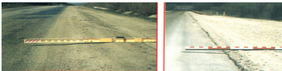
Рис. 4. Пример завышения обочин по отношению к проезжей части дороги при отсутствии бордюра
