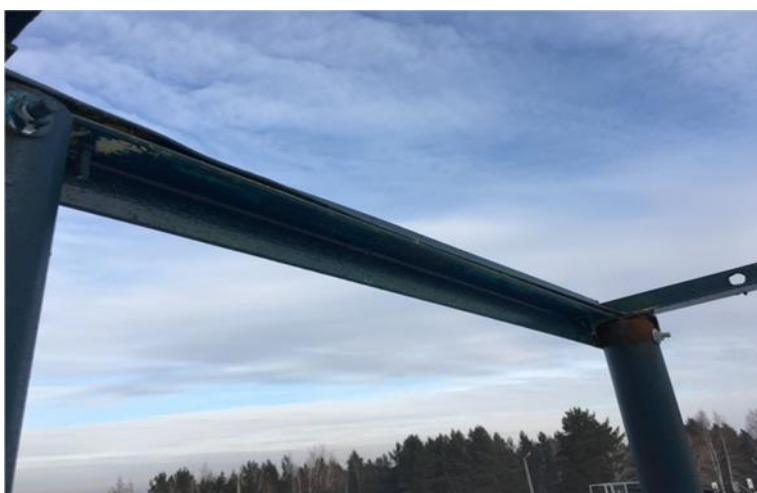
Рис. 2.3. Гимнастическая перекладина из металлического уголка высота 210 см; размер металлического уголка 45 мм
