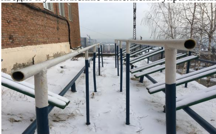
Рис. 2.1. Разновысотные параллельные брусья общая длина 20 м; длинна одного положения 10 м; высота первой параллели 1,1 м; высота второй параллели 1,3 м; ширина между перекладинами 0,4 м
