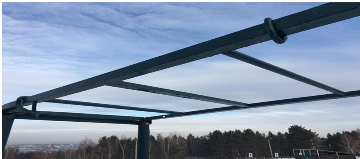
Рис. 2.4. Гимнастический рукоход из металлического уголка начальная высота рукохода — 250 см; середина — 350 см; конечная высота — 250 см; расстояние между перекладинами 40—50 см
